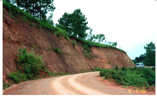
รูปที่ 3 การตัดลาดดินในลาดเขา
